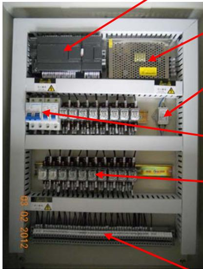
PLC 主模块：上行输出信号 Q，下行输入信号 I
